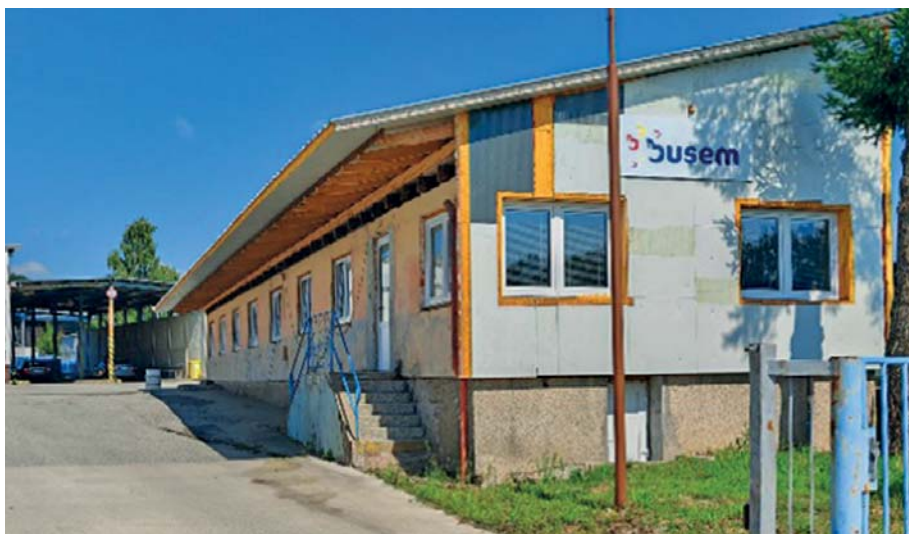
Rekonstrukcí v Dačicích prošla i bývalá budova ČSAD, v níž mají nyní zázemí dispečerů i řidiči.
